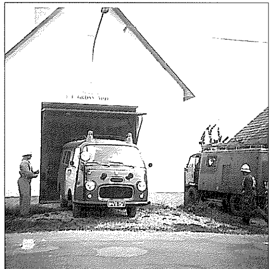
Neues Gerätehaus (erb. 1964) mit Kleinlöschfahrzeug "Fiat 1300"
